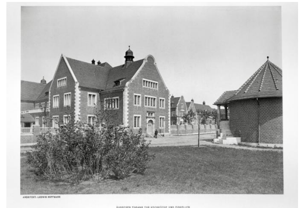
Abb. 5: Äußerer Zugang Kochküche und Eiskeller, 1908
