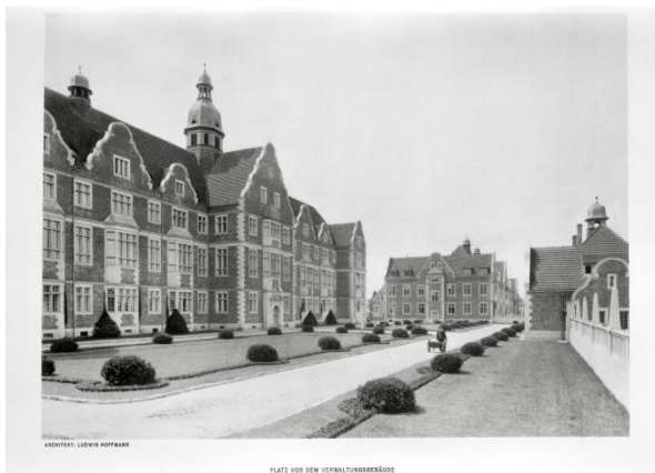
Abb. 4: Platz vor dem Verwaltungsgebäude, 1908
