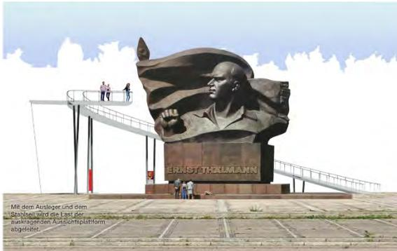
Mit dem Ausleger und dem Sockel wird die Fassade auskragendem Aussichtsplattform abgeleitet.
